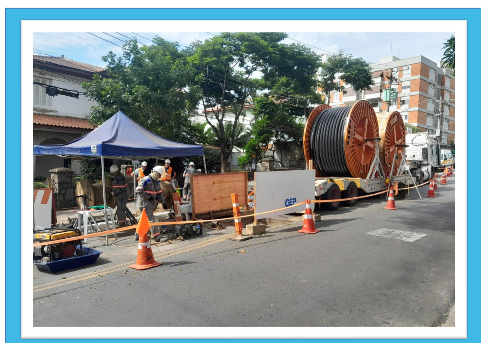
Lançamento de cabo da caixa T para a caixa 1 – circuito 3
